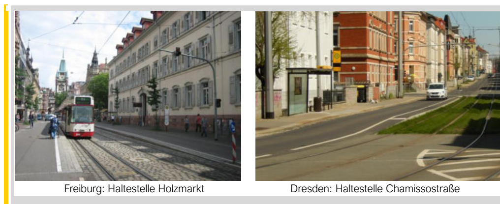
Abbildung 5.4: Praxisbeispiele Haltestelle mit angehobener Fahrbahn
