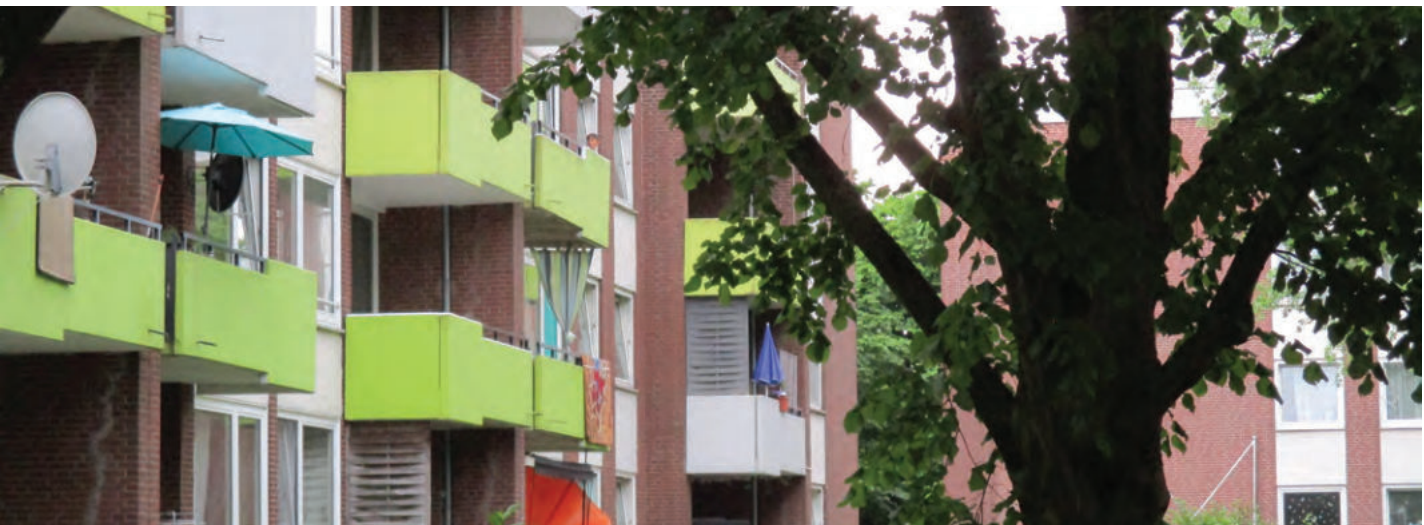
Abb. 21: Geschosswohnungsbau Lüssumer Heide im Bestand der GEWOBA
