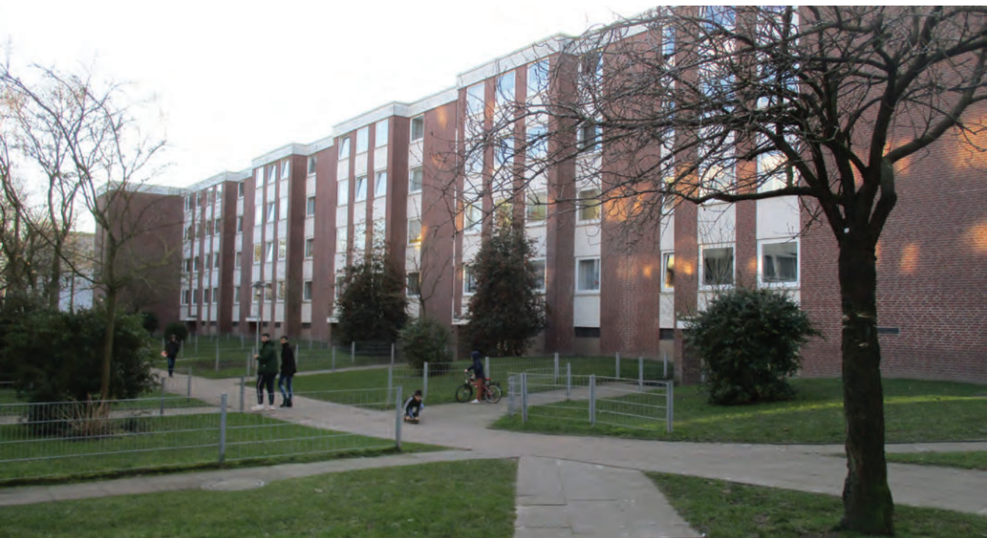
Abb. 11: Geschosswohnungsbau Lüssumer Heide im Bestand der GEWOBA
