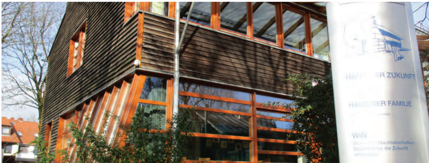
Abb. 25: Quartierszentrum in Lüssum: das Haus der Zukunft
