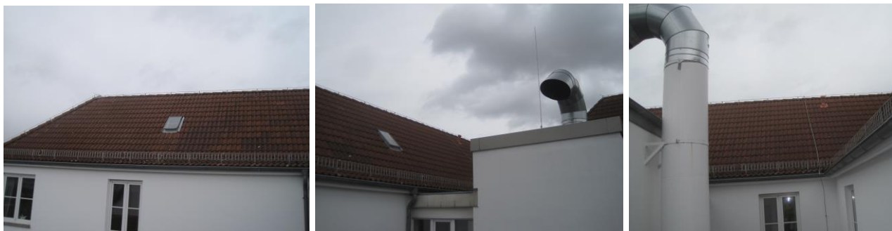
Abbildung 3: Blick auf das Schrägdach, das zum Innenhof zeigt
