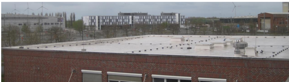
Abbildung 5: Blick auf das Hallendach
