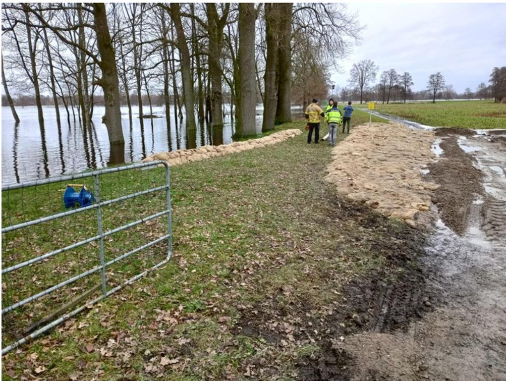
Abbildung 1 Deich in Timmersloh: Darstellung der Problematiken von Baumbewuchs, Standsicherheit und Höhe.
