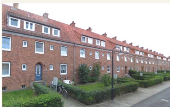
Abbildung 17 Denkmalgeschützte Siedlung Auf dem Beginenlande
