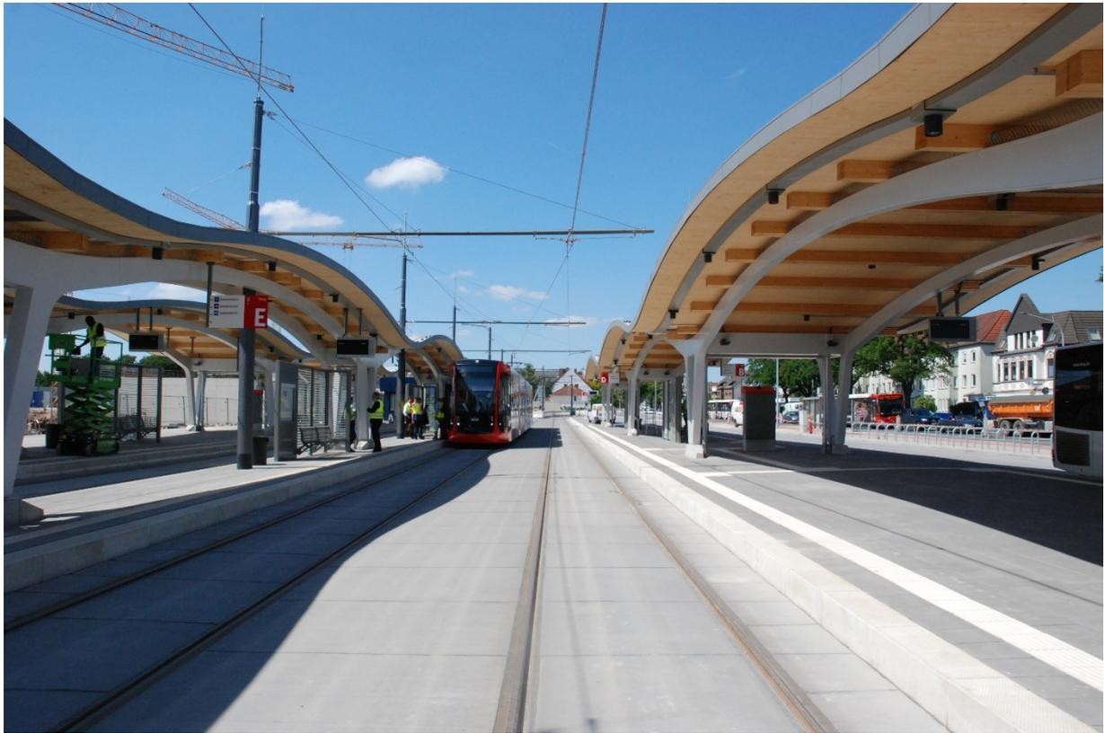
Eine Bordhöhe von 22 cm gilt auch im Umland für einen niveaugleichen Einstieg (bei geradliniger Anfahrt). An Haltestellen, an denen eine gerade Anfahrt nicht umgesetzt werden kann, sowie an den Haltestellen, die von Bussen angefahren werden, die eine Bordhöhe von 22 cm noch nicht bedienen können, müssen weiterhin die fahrzeuggebundenen Einstiegshilfen genutzt werden.
