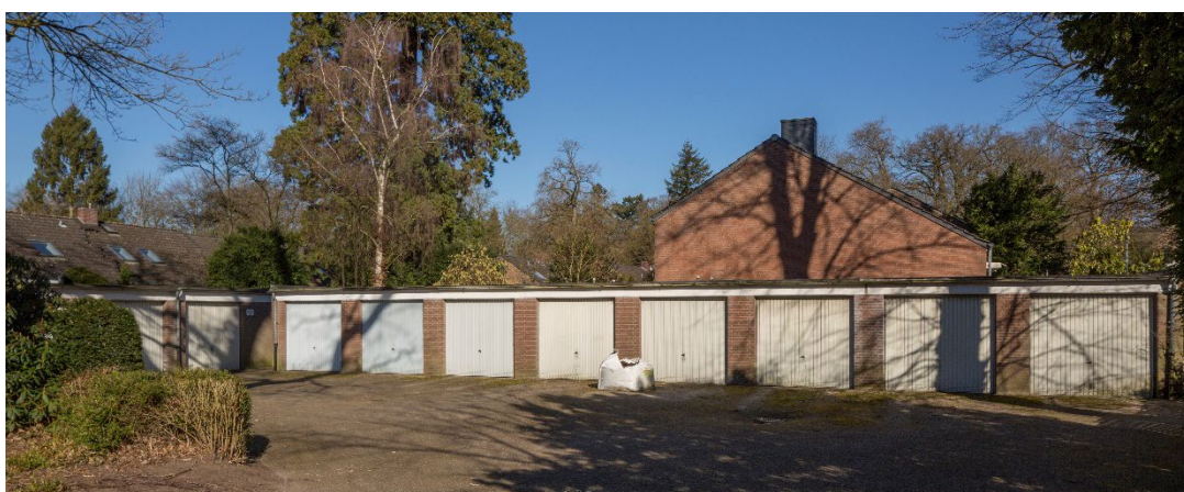
Abbildung 15: Sammelanlage an der Straße Birkenhof (Quelle: N. Wolff, Fotoetage)
