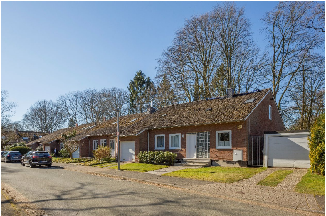
Abbildung 26: Reihenhausansichten Straßenseite (Quelle: N. Wolff, Fotoetage)
