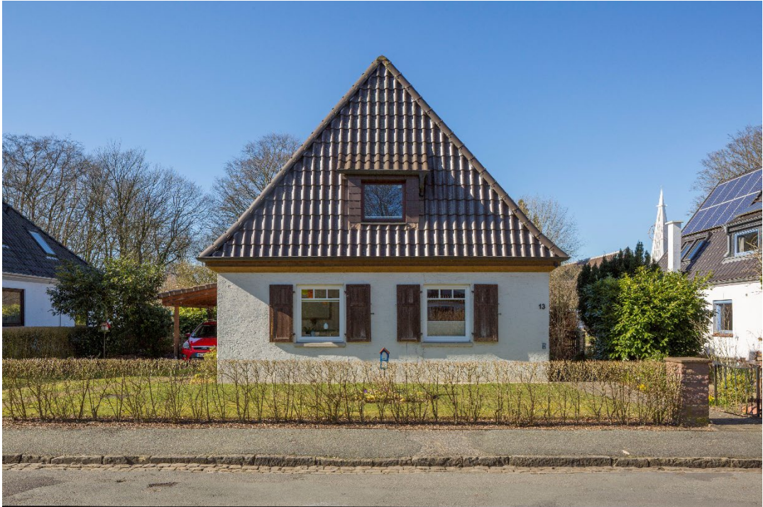
Abbildung 7: Einfamilienhaus (Quelle: N. Wolff, Fotoetage)
