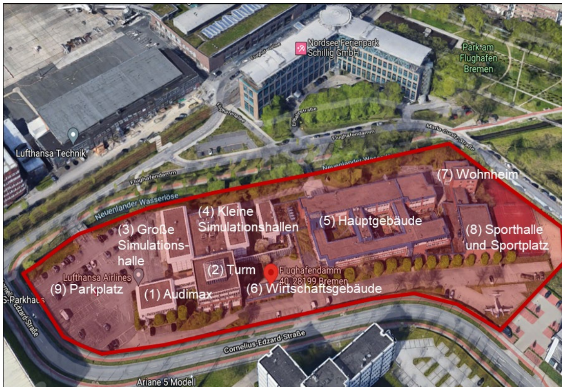
Abbildung 1: Luftbild LAT-Liegenschaft Flughafendamm 40
