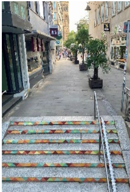
Treppenaufgang in der Bischofsnadel
