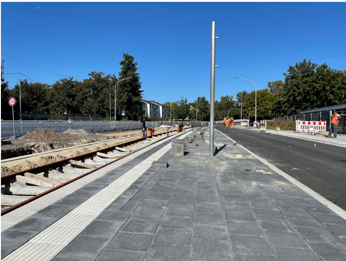
Abb. 1 Linie 1 Baumaßnahme Heinrich-Plett-Allee, © CTB 05.09.2023
