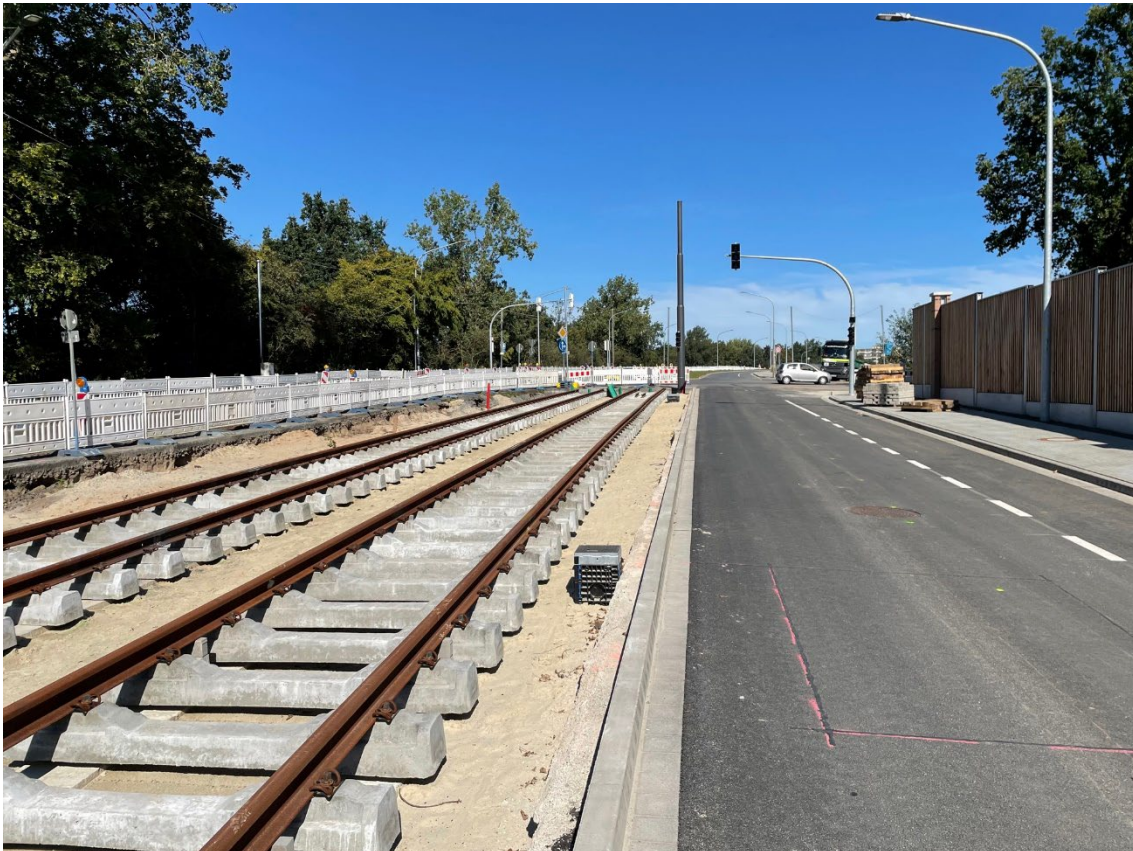
Abb. 2 Linie 1 Baumaßnahme Heinrich-Plett.Allee/B75, © CTB 05.09.2023
