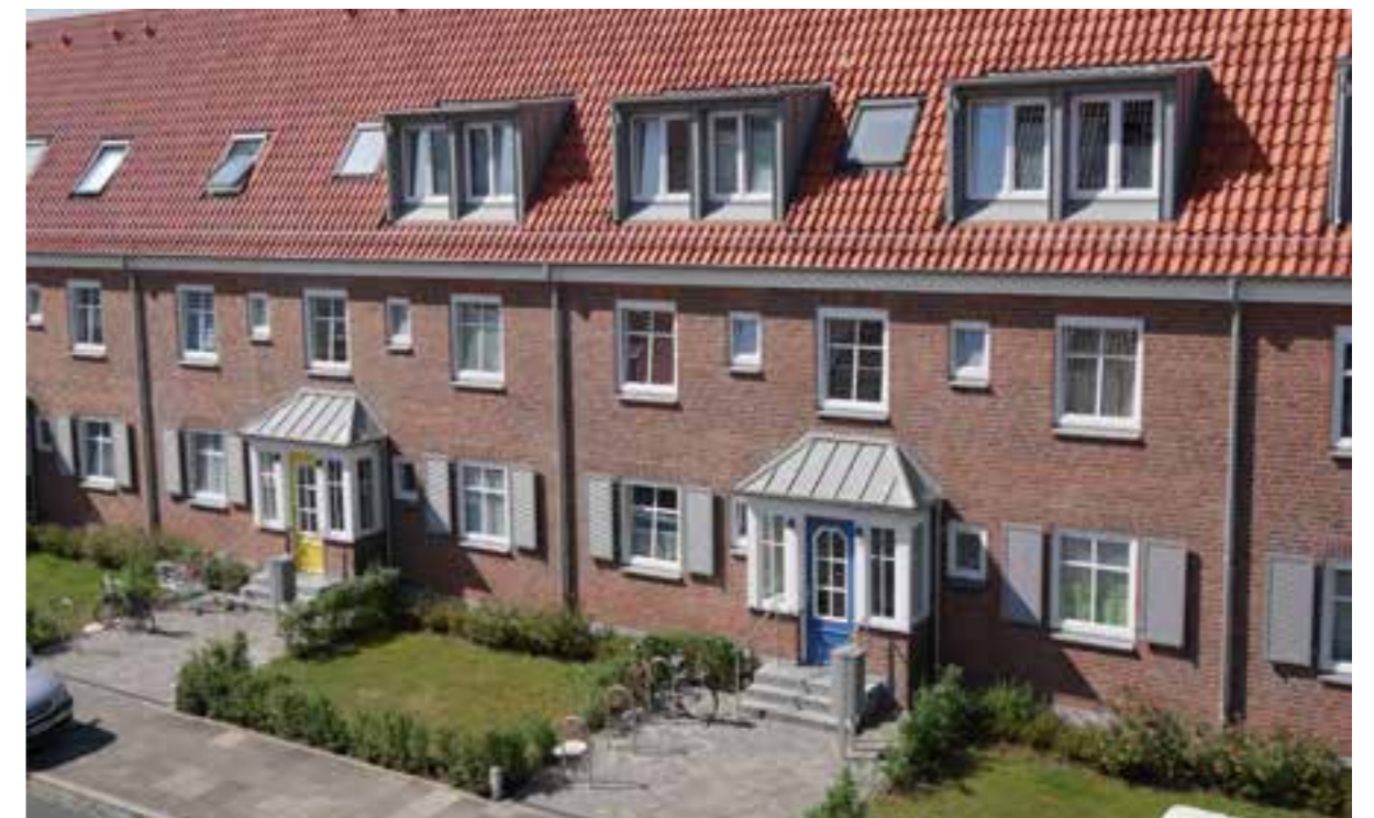
In Zukunft ggf. auch Wohnstandort für Studierende – sanierte Wohngebäude aus den 1930er Jahren in der Greifswalder Straße
