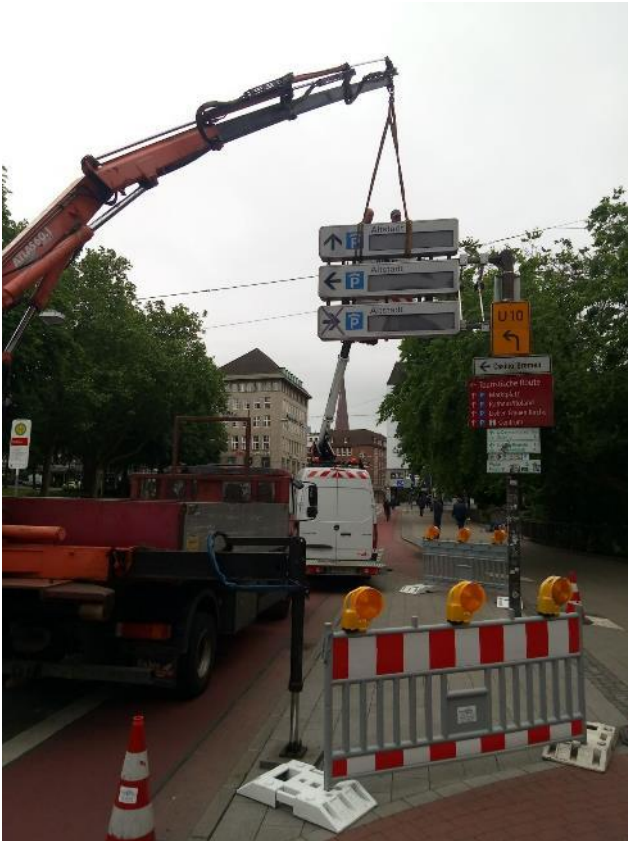
Abbildung 4-47: Anpassungsarbeiten am Parkleitsystem nach Umbaumaßnahmen im Herdentor, Quelle SKUMS
