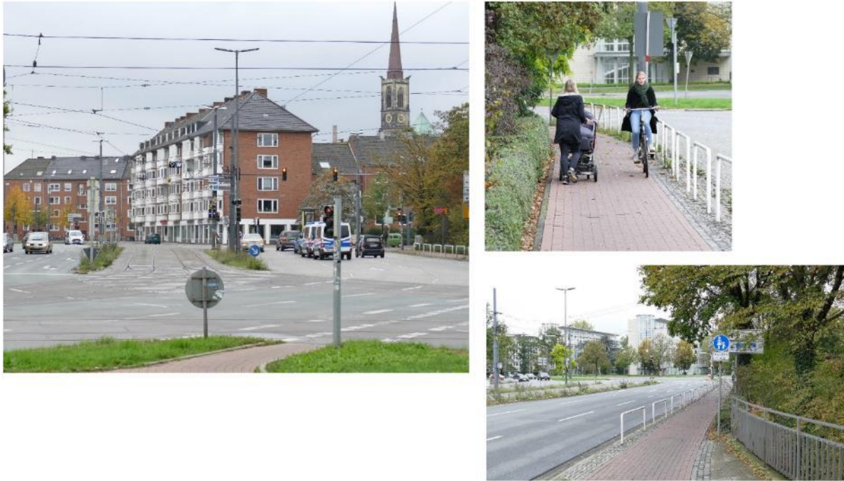
Abbildung 2-19 Bestandssituation Seiten- und Straßenraum, Quelle: Machbarkeitsstudie Doventor – SHP Ingenieure
