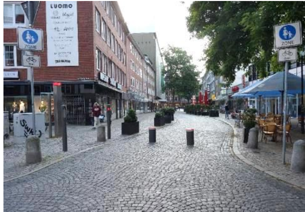
Abbildung 4-5: eine neue Fußgängerzone entsteht – versenkbare Poller in der Knochenhauerstraße, Quelle: SKUMS
