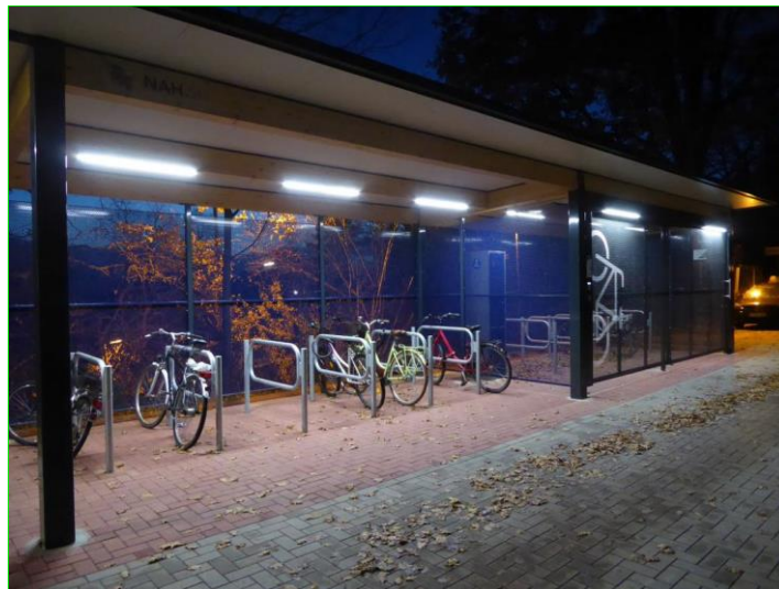
Abbildung 7-2: Ein mögliches Vorbild für B+R: Der Anlagentyp SH (Schleswig-Holstein), Foto: Wilhelm Hamburger.
