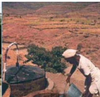
Biogasanlagen reduzieren den CO 2 -Ausstoß und liefern Gas zum Kochen. Der entstehende Faulschlamm ist ein wertvoller Dünger.
