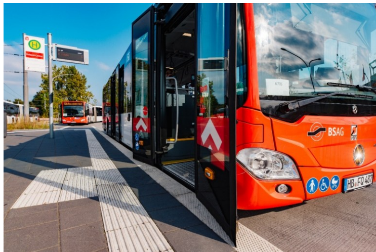
Abbildung 6: Umsteigeanlage Roland-Center, Sonderbord zum niveaugleichen Einstieg und Blindenleitsystem (© SBMS/Jonas Ginter)
