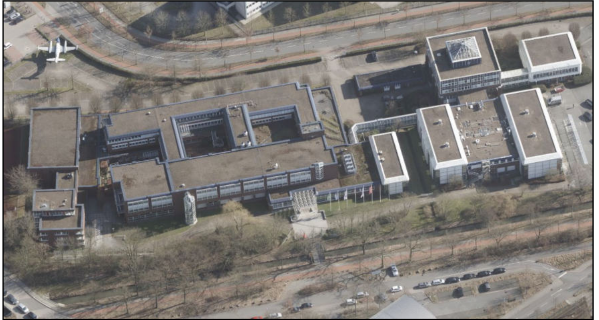
Schrägluftbild (Stand 2025) aus westlicher Richtung – Gesamtansicht Gebäude
