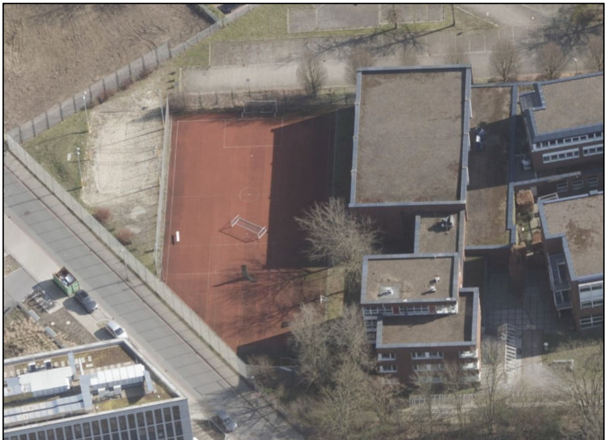
Schrägluftbild (Stand 2025) aus westlicher Richtung – Wohnheim, Sporthalle, Sportplatz
