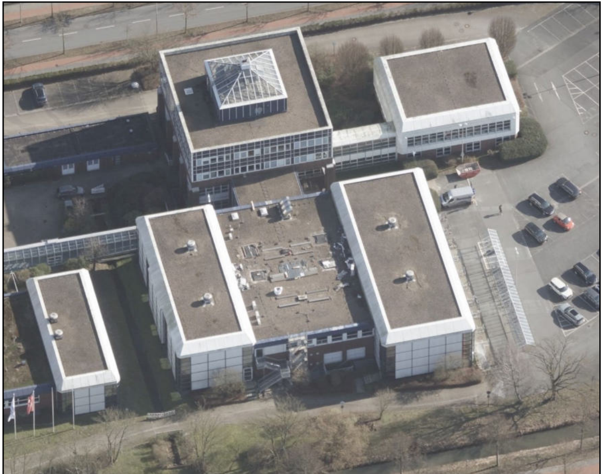
Schrägluftbild (Stand 2025) aus westlicher Richtung – Turmgebäude, Audimax, Simulatorenhallen
