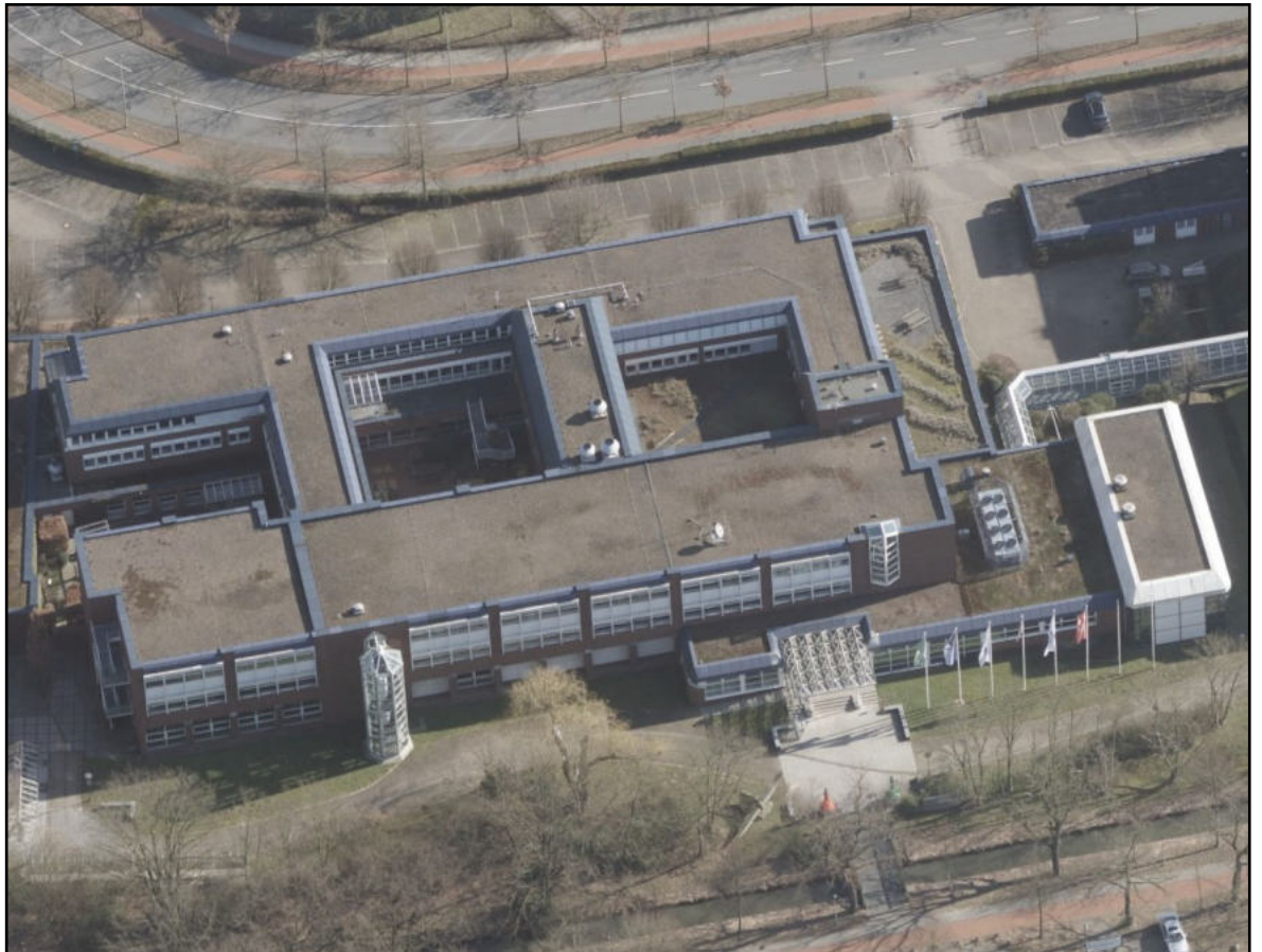
Schrägluftbild (Stand 2025) aus westlicher Richtung – Haupteingang mit Hauptgebäude
