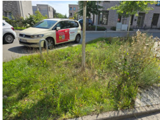
Abb. 62: Das Niederschlagswasser der angrenzenden Flächen fließt in die Mulde der Baumscheibe. Foto: SUKW / Iris Bryson.
