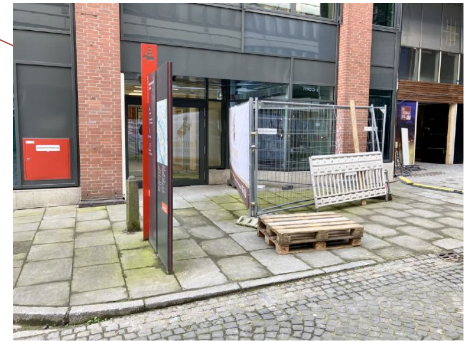
vorh. Sandsteinplatten auf dem Gehweg Ansgaritorstraße, Lloydhofseite
