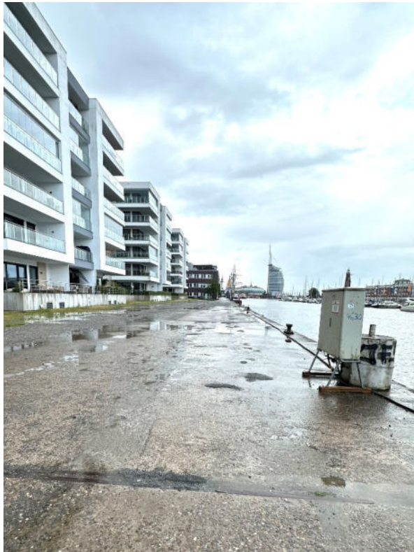
Abb. 2: Nordostkaje, Blickrichtung Süd, nicht sanierter Bereich
