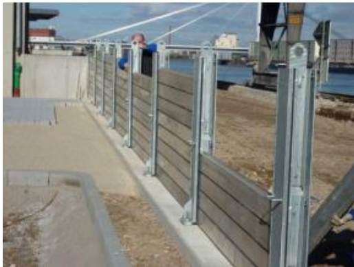
Abbildung 15 Varianten von mobilen Hochwasserschutzsystemen
