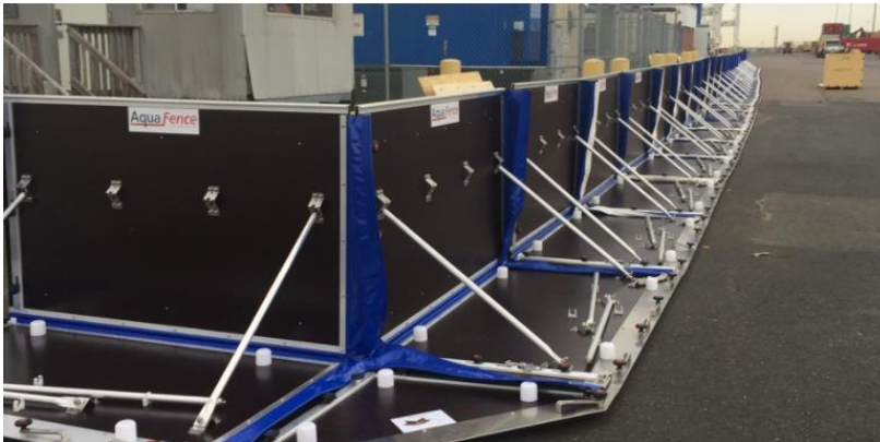
Abbildung 12: Foto eines mobilen Hochwasserschutzes als Klappsystem [U28]
