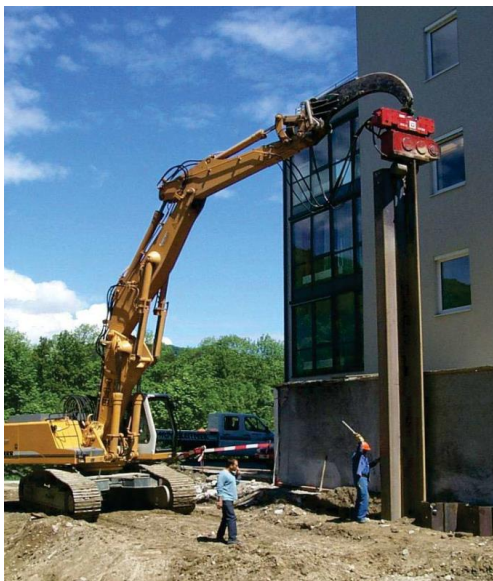
Abbildung 18 Variante Spundwandeinbringung neben einem Gebäude [U8]
