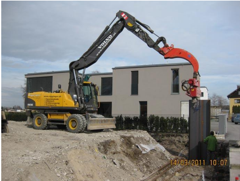
Abbildung 19 Variante Spundwandeinbringung [U8]
