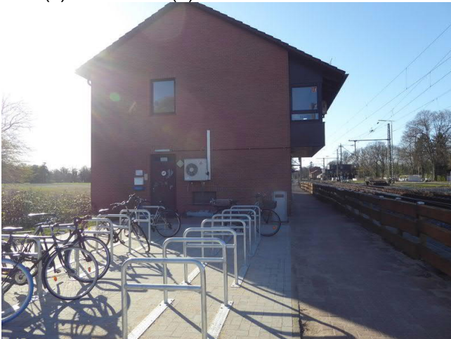
Standort für überdachte Anlage an Gleis 3
