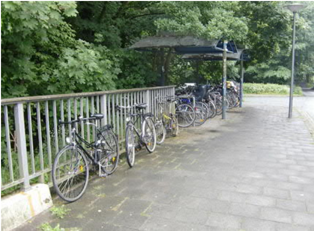
Erneuerung der überdachten Anlage
