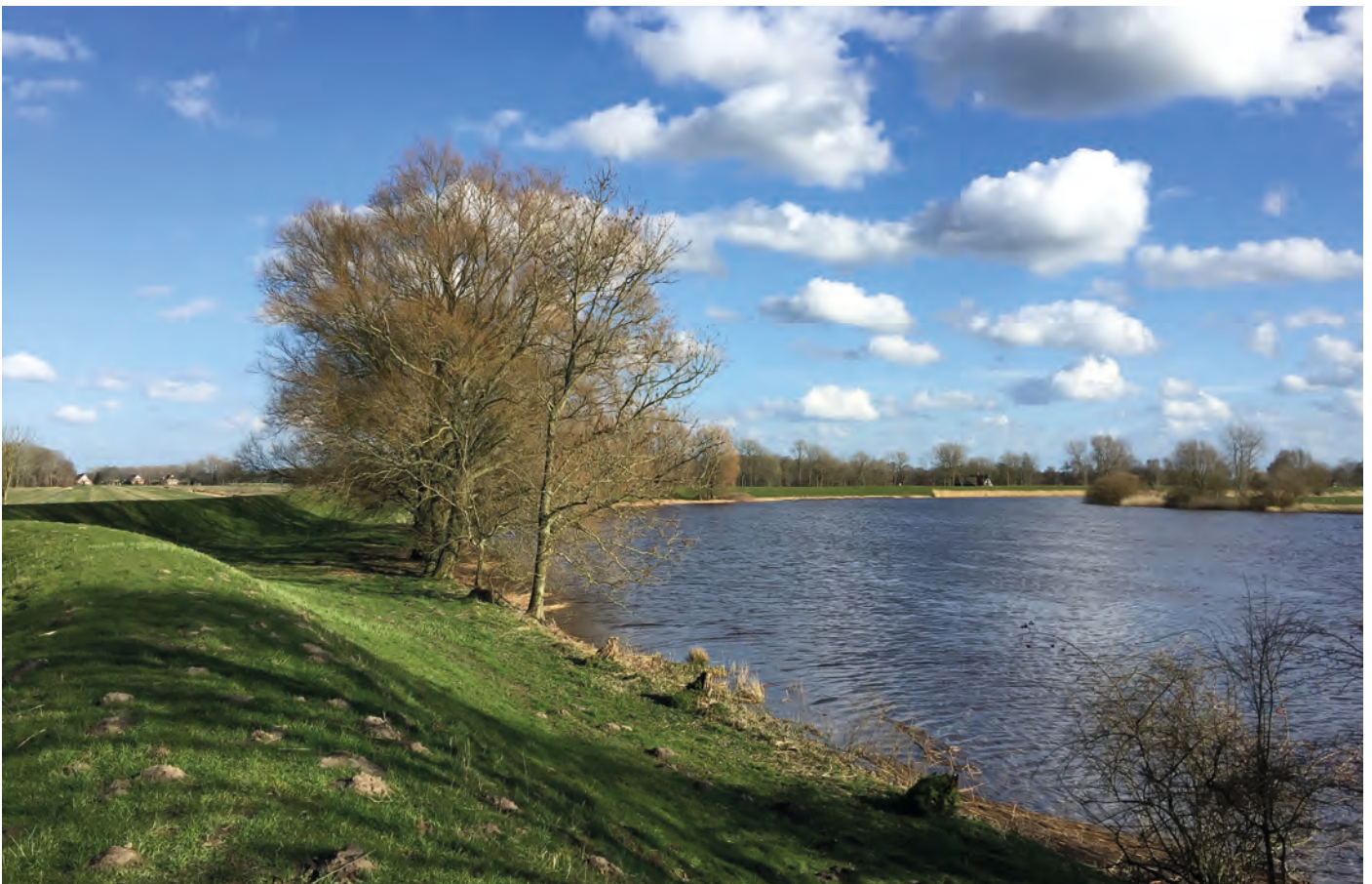
Abb. 1-4: Schutzdeiche an der Oste
