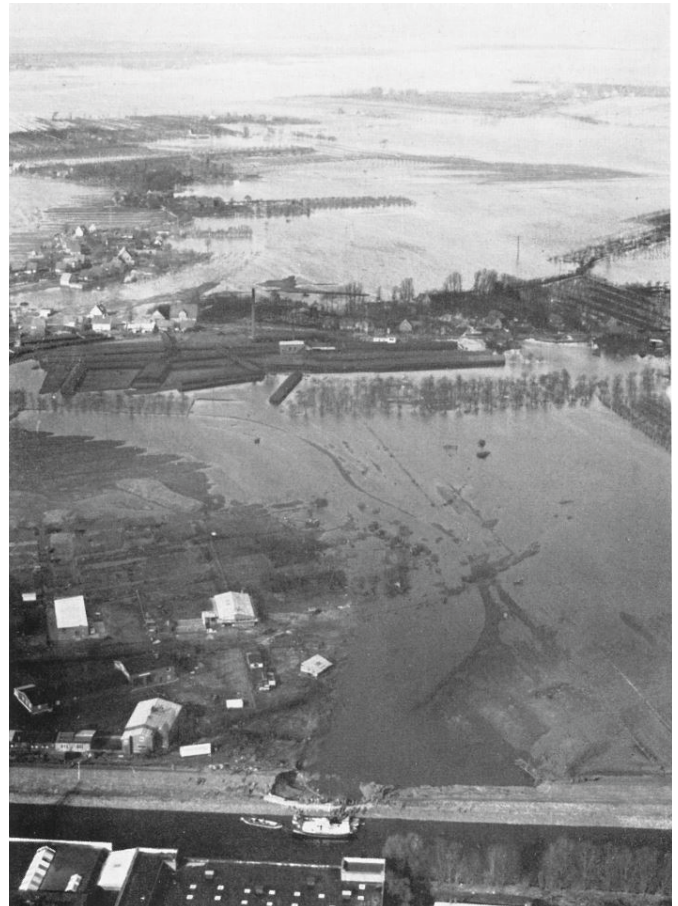
Abb. 1-1: Deichbruch an der Schwinge bei Stade im Februar 1962
