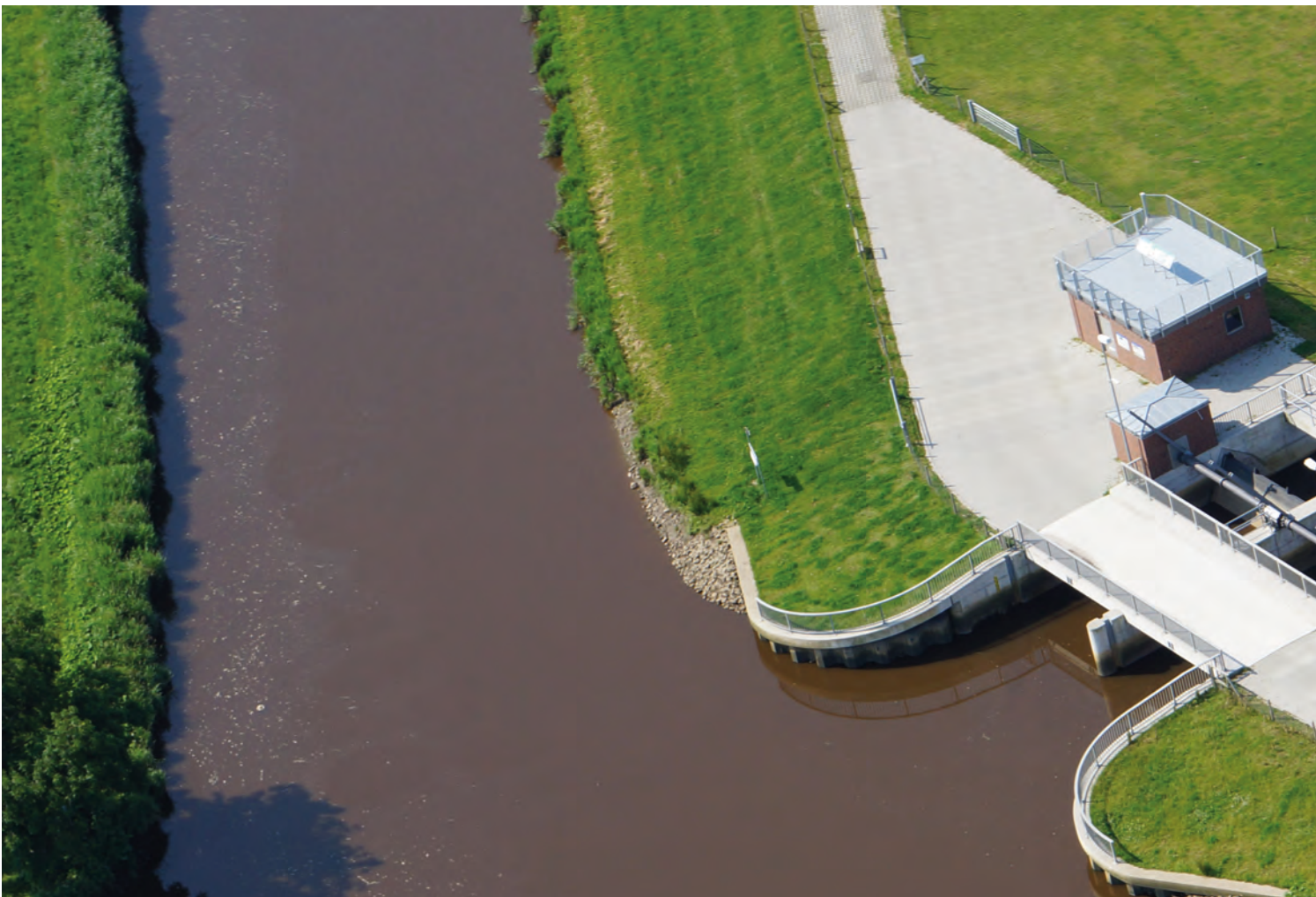
Abb. 6-2: Einlassbauwerk am Flutpolder Holter Hammrich
