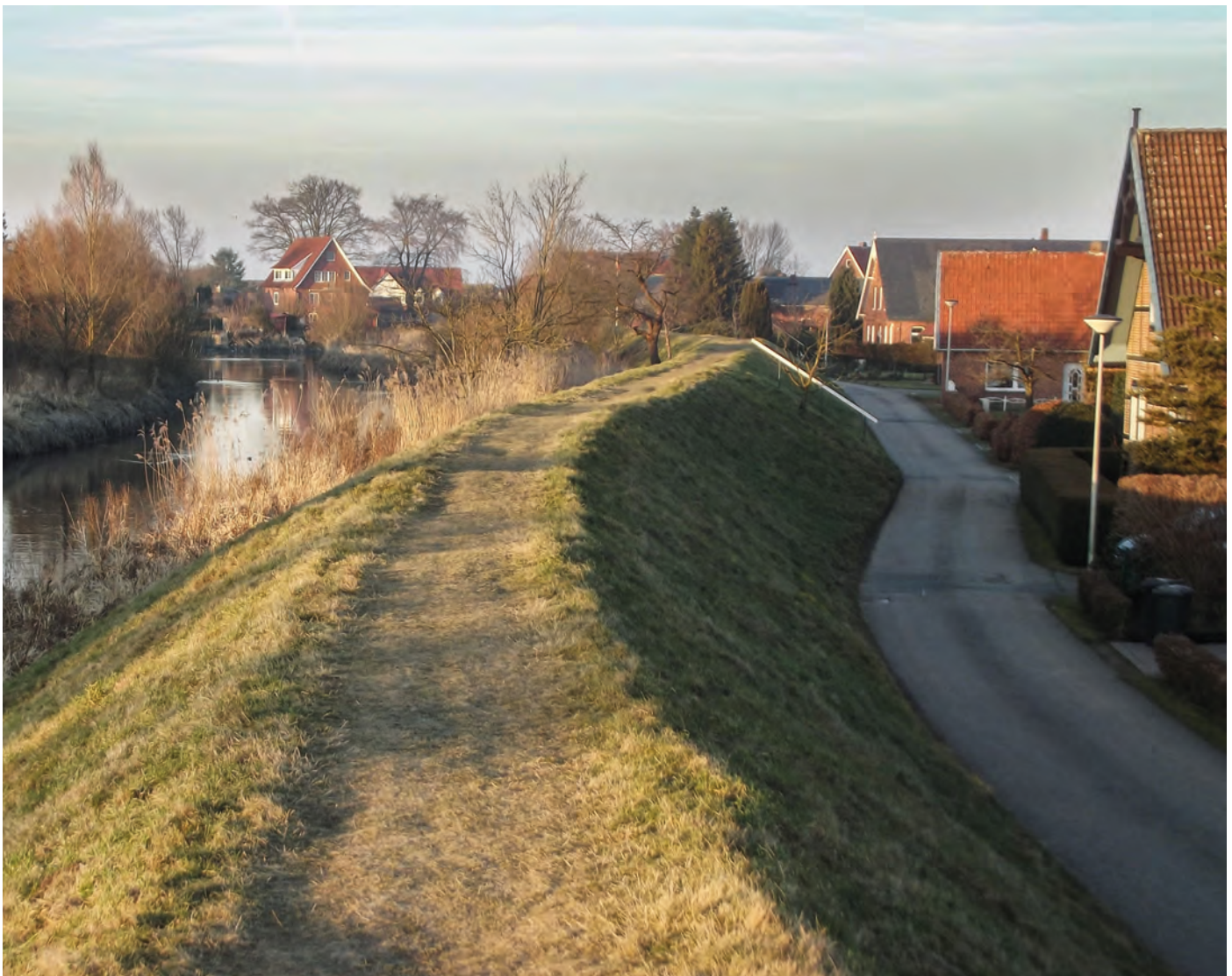
Abb. 2-4: Schutzdeiche an der Lühe
