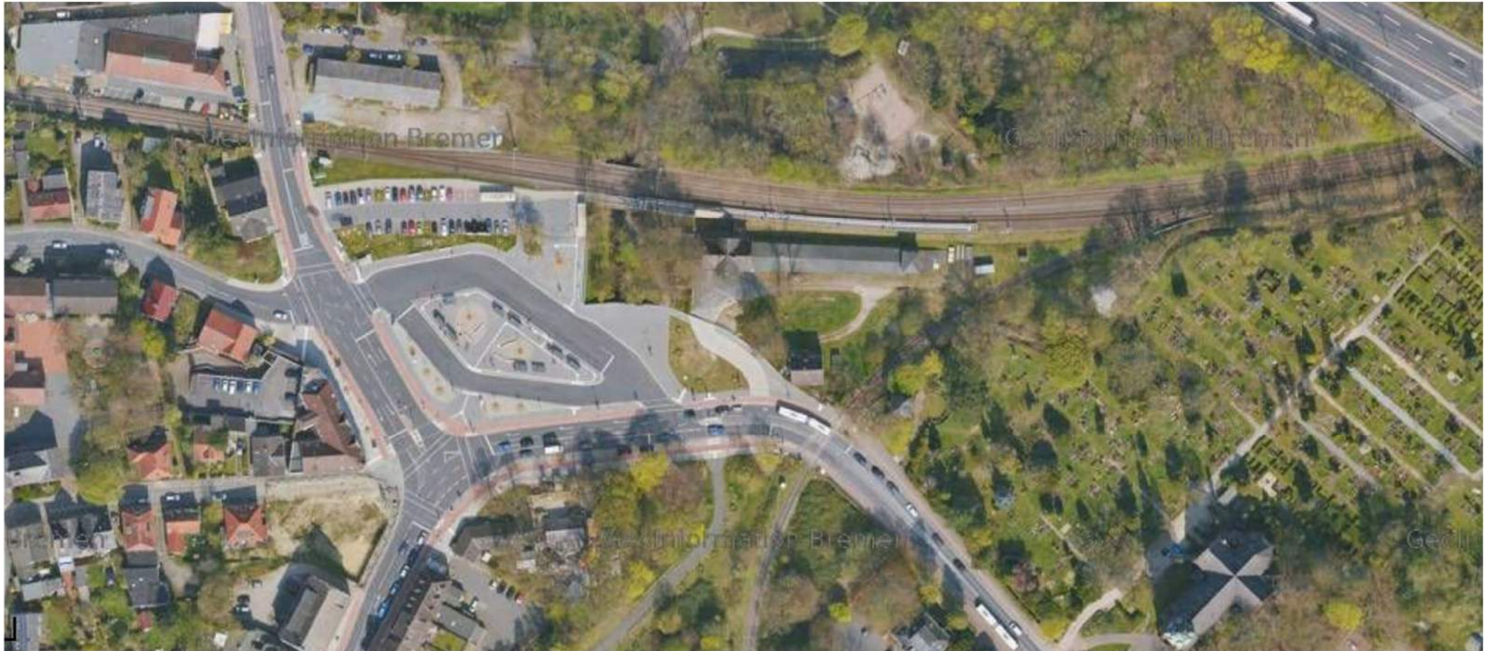
Abb. 2: Luftbild Plangebiet Quelle: Geoinformation Bremen 2019
