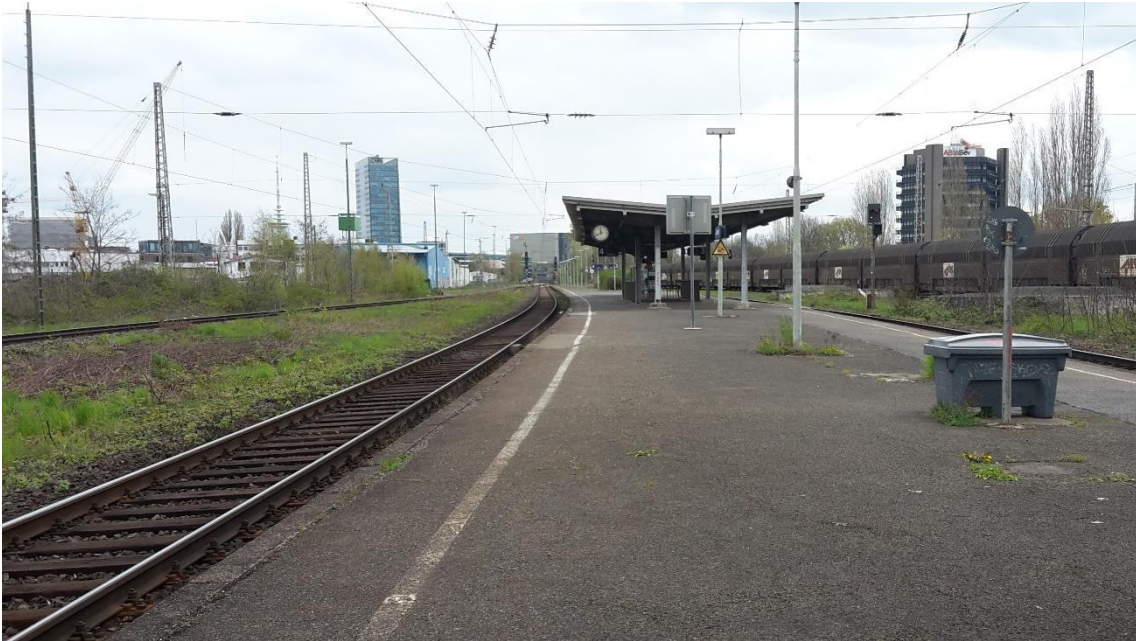
Bestandsituation des Mittelbahnsteigs in Bremen-Neustadt (2020)
